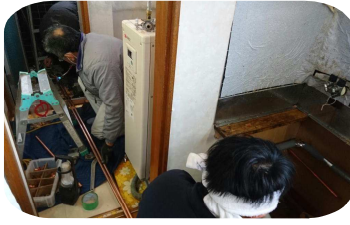
12月…念願の水道配管付替え 綺麗な水の勢いに感激! (3人の作業員の方が一日がかりで…)
