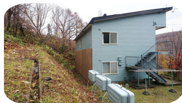
11月末、冬期対策の冬囲い完了! (壁面被害の住宅棟も修繕後に補強)
