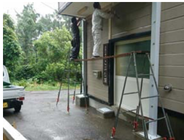
補強工事中の「搬入口」の様子
