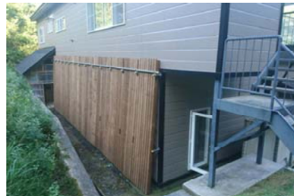
修繕事業後の本部棟・西側壁面
